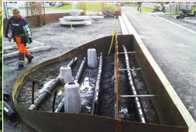
Stålkonstruktionen vid Landvetters busscentral under uppbyggnad av bevattningssystemet.
