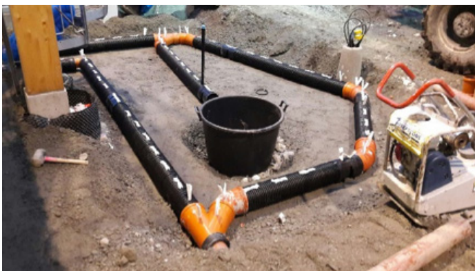
Arbetet med Bovieran i Enköping
